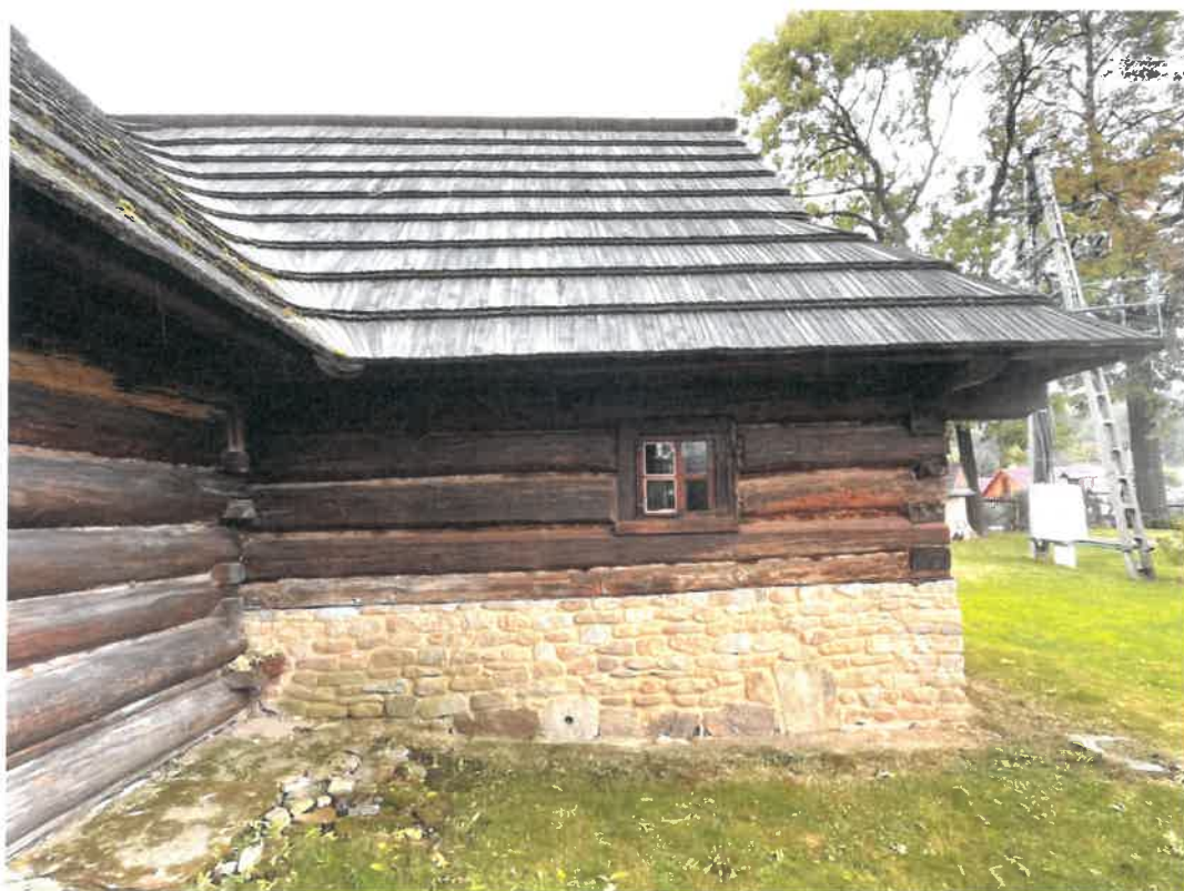
Fot. nr 8 Fot. nr 9 Muzeum „Stara Chalupa“, 1739, skansen w Milówce. Strona północna; widoczna korozja biologiczna dachu gontowego, kamienna opaska wokół domu.
