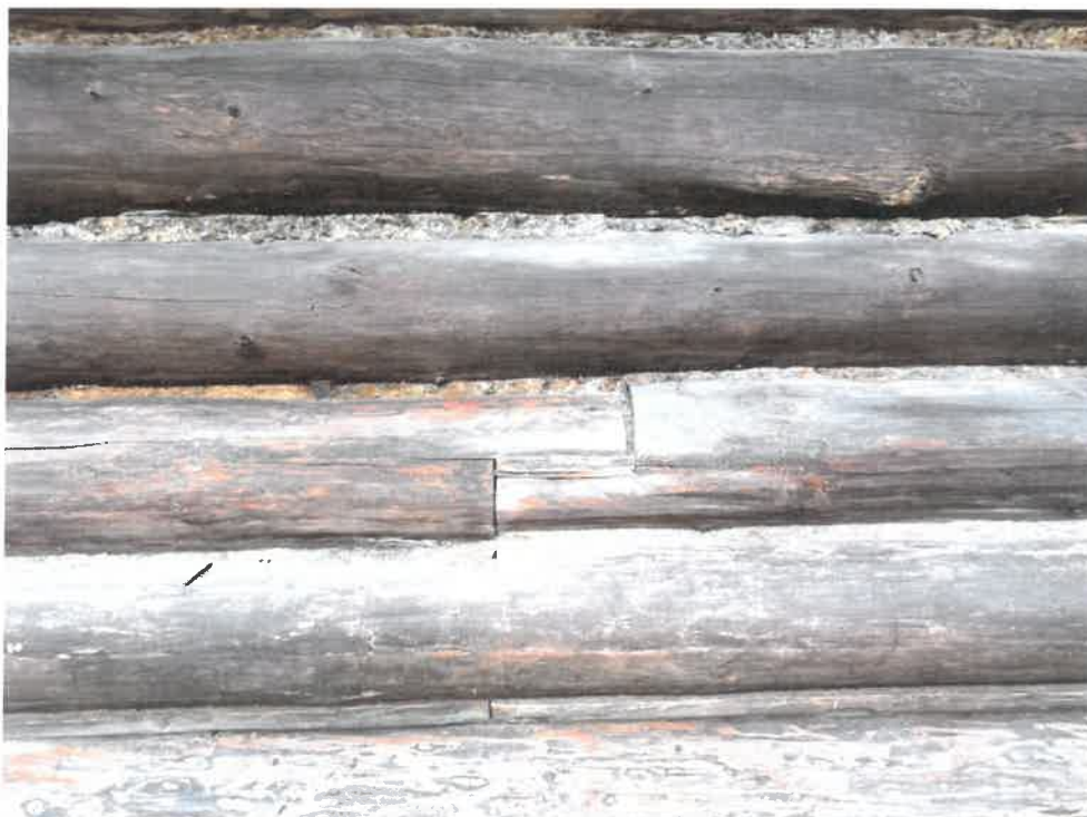
Fot. nr 18, Fot. nr 19 20Muzeum „Stara Chalupa“, 1739, skansen w Milówce. Strona północna; widoczne uzupełnienia belek łączonych na zakładkę, pęknięcia wzdłużne bali oraz ubytki mszenia.
