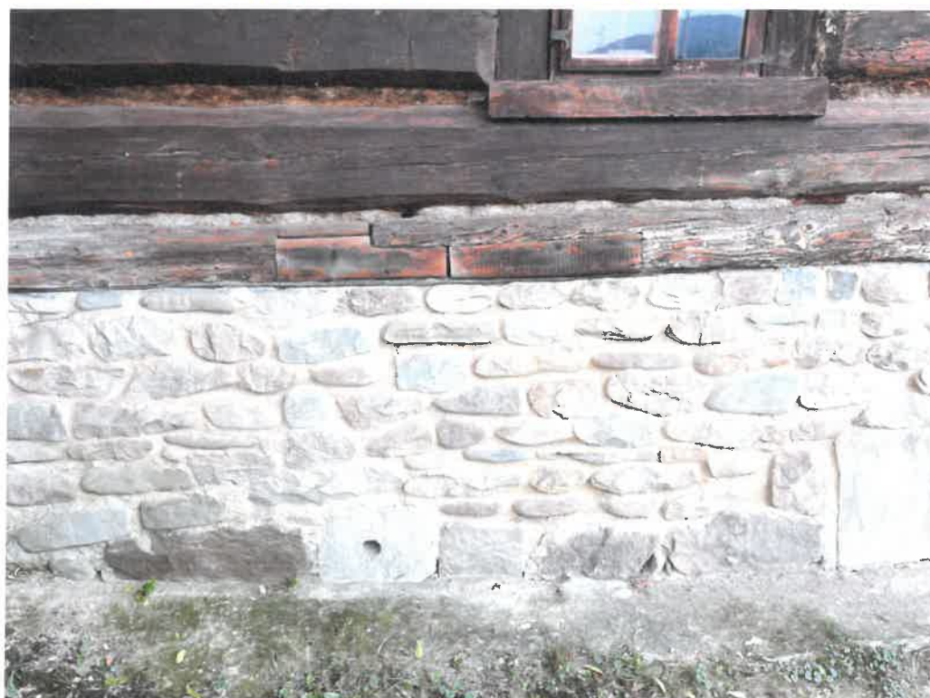
Fot. nr 10 Fot. nr 11 Muzeum „Stara Chalupa“, 1739, skansen w Milówce. Strona północna; widoczne ubytki mszenia i gniazdo kuny w narożniku północnym – części piwnicznej. Widoczne wstawki drewniane w obrębie bali z czasów poprzedniej konserwacji i cokół kamienny fugowany z wierzchu gliną.
