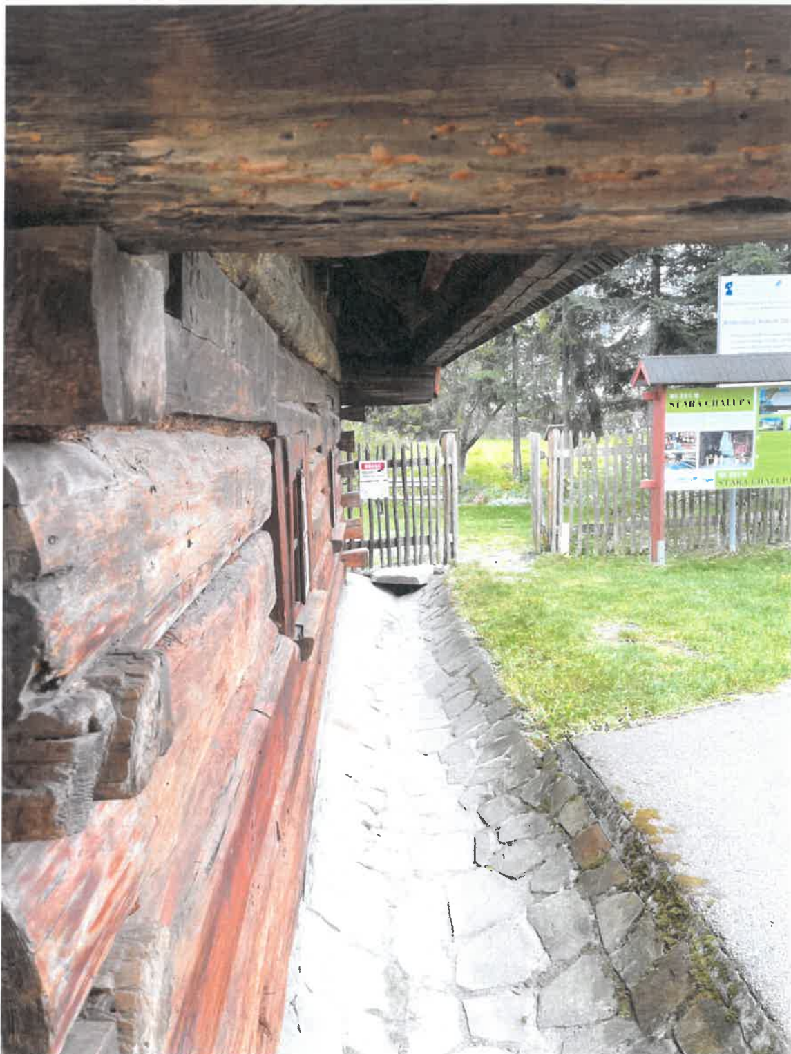
Fot. nr 7 Muzeum „Stara Chalupa“, 1739, skansen w Milówce. Strona południowa. Widoczne koryto odprowadzające wodę oraz belki porażone działalnością owadzych szkodników.
