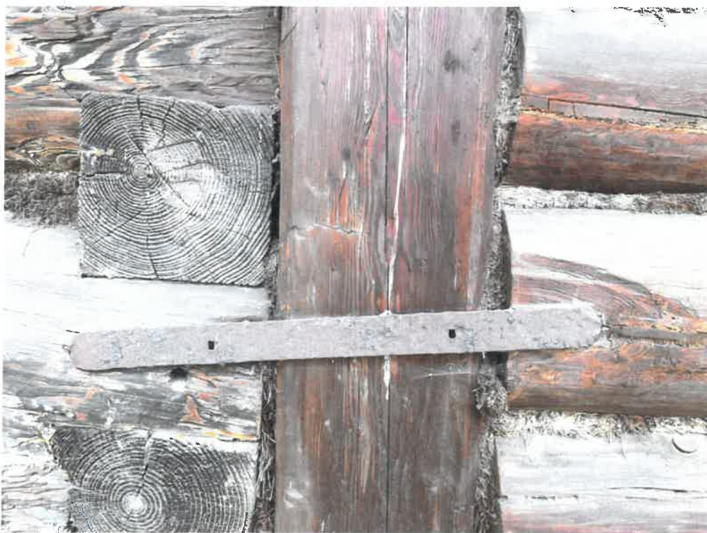
Fot. nr 28 Fot. nr 29 Muzeum „Stara Chalupa“, 1739, skansen w Milówce. Strona północna; widoczne ubytki mszenia, oraz skorodowane klamry metalowe spinające bale.
