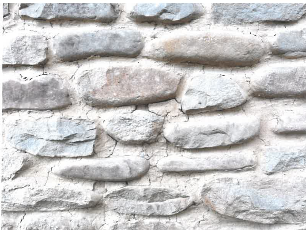
Fot. nr 12 Fot. nr 13 Muzeum „Stara Chalupa“, 1739, skansen w Milówce. Strona północna, fragment cokołu kamiennego z fugą cementową i wierzchnią glinianą. Widoczne spękania i wykruszenia warstwy gliny.
