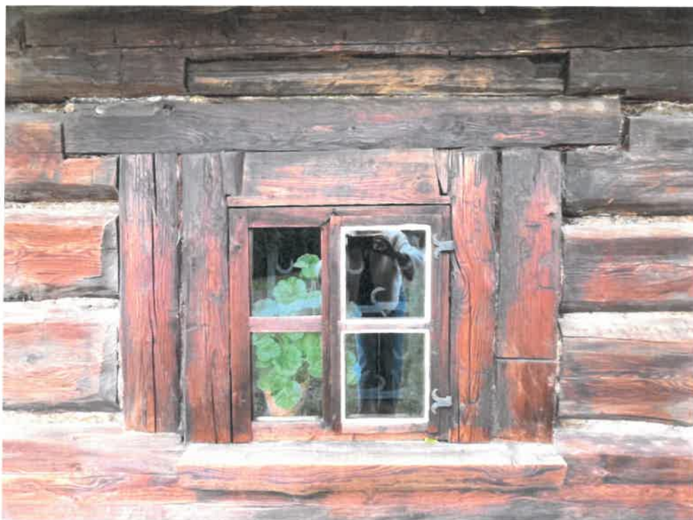
Fot. nr 3 Fot. nr 4 Muzeum „Stara Chalupa“, 1739, skansen w Milówce. Strona południowa, widoczne uzupełnienia belek elewacji oraz ubytki w obrębie gontów.
