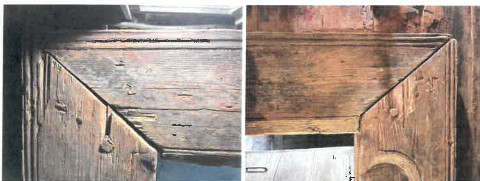
Fot. nr 41 Fot. nr 42 Fot. nr 43 Muzeum „Stara Chalupa“, 1739, skansen w Milówce. Wnętrze głównej izby, drewniany portal w głównej izbie. Widoczne rozszczelnienia połączeń ciesielskich, drobne ubytki drewna.
