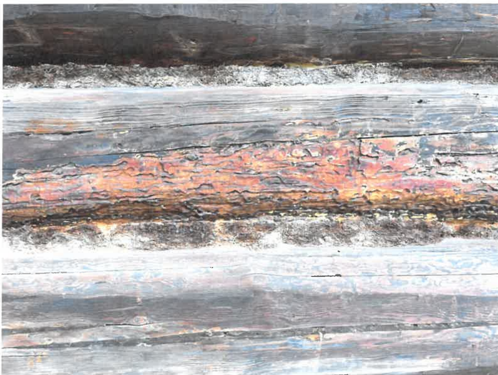
Fot. nr 14, Fot. nr 15 Muzeum „Stara Chalupa“, 1739, skansen w Milówce. Strona północna; widoczne belki porażone działalnością owadzych szkodników. Pęknięci wzdłużne drewna oraz zmurszałe mszenie.
