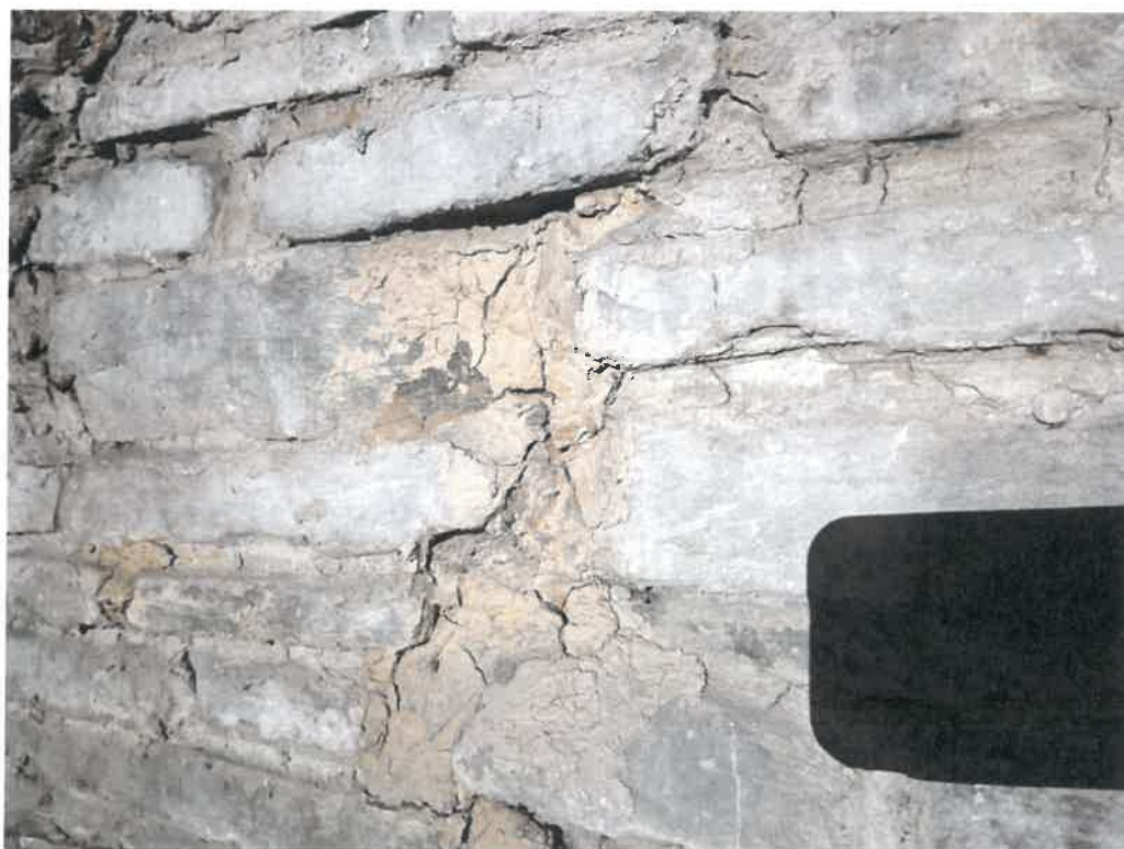
Fot. nr 34 Fot. nr 35 Muzeum „Stara Chalupa“, 1739, skansen w Milówce, piwnica. Widoczne zawilgocenie w narożniku oraz spękane i osypujące się spoiny gliniane oraz pudrująca się warstwa wapna występująca na ścianach i sklepieniu.
