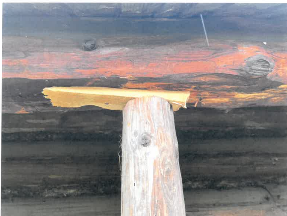
Fot. nr 26, Fot. nr 27 Muzeum „Stara Chalupa“, 1739, skansen w Milówce. Strona zachodnia; widoczne prowizoryczne uzupełnienia drewnianych elementów, ubytki drewna i elementów dachu, ślady działalności owadów szkodników.
