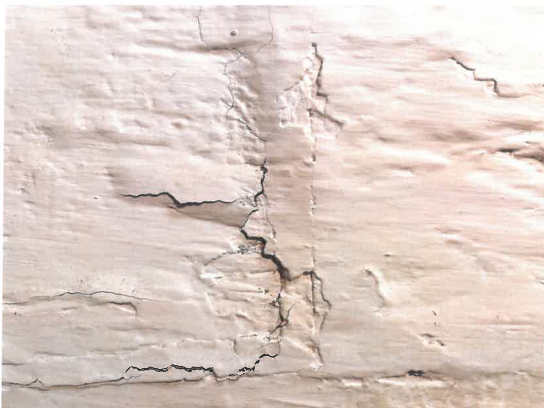
Fot. nr 39Fot. nr 40 Muzeum „Stara Chalupa“, 1739, skansen w Milówce. Wnętrze, widoczne spękania i osypywanie się skorupy wapiennej na ścianach mniejszej izby.
