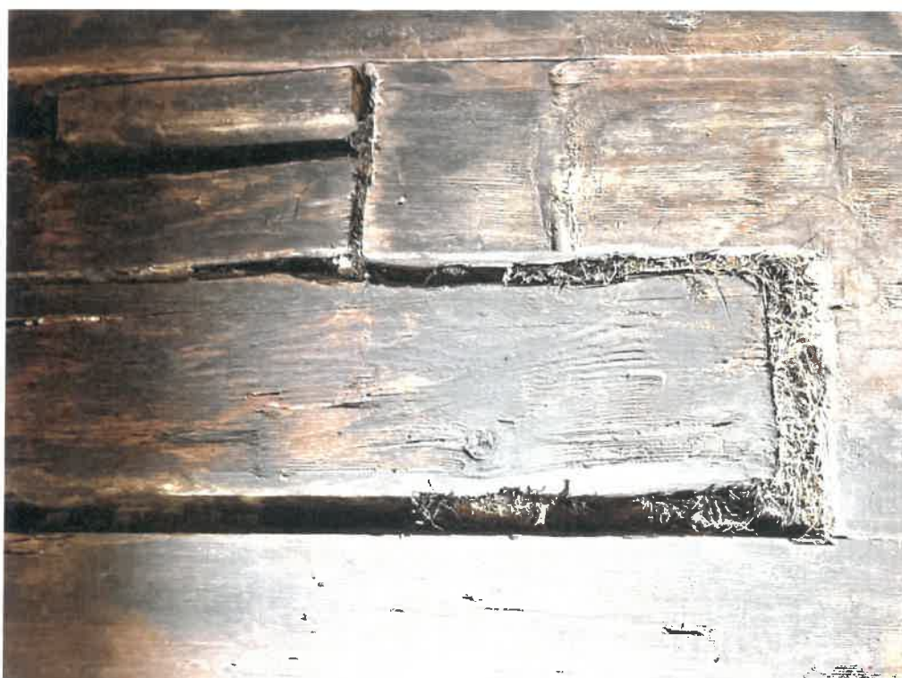
Fot. nr 44 Fot. nr 45 Muzeum „Stara Chałupa“, 1739, skansen w Milówce. Wnętrze głównej izby, widoczne ubytki drewna – korytarze będące działalnością owadźich szkodników, ubytki mszenia w przestrzeniach powstałych przez niedopasowanie wstawek drewnianych.
