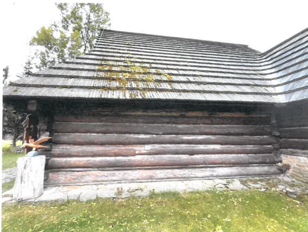
Fot. nr 16, Fot. nr 17 Muzeum „Stara Chalupa“, 1739, skansen w Milówce; strona północna. Widoczne: wysunięte w stosunku do lica uzupełnienia belek, izolacja z papy, porosty i mech na gontowym dachu.
