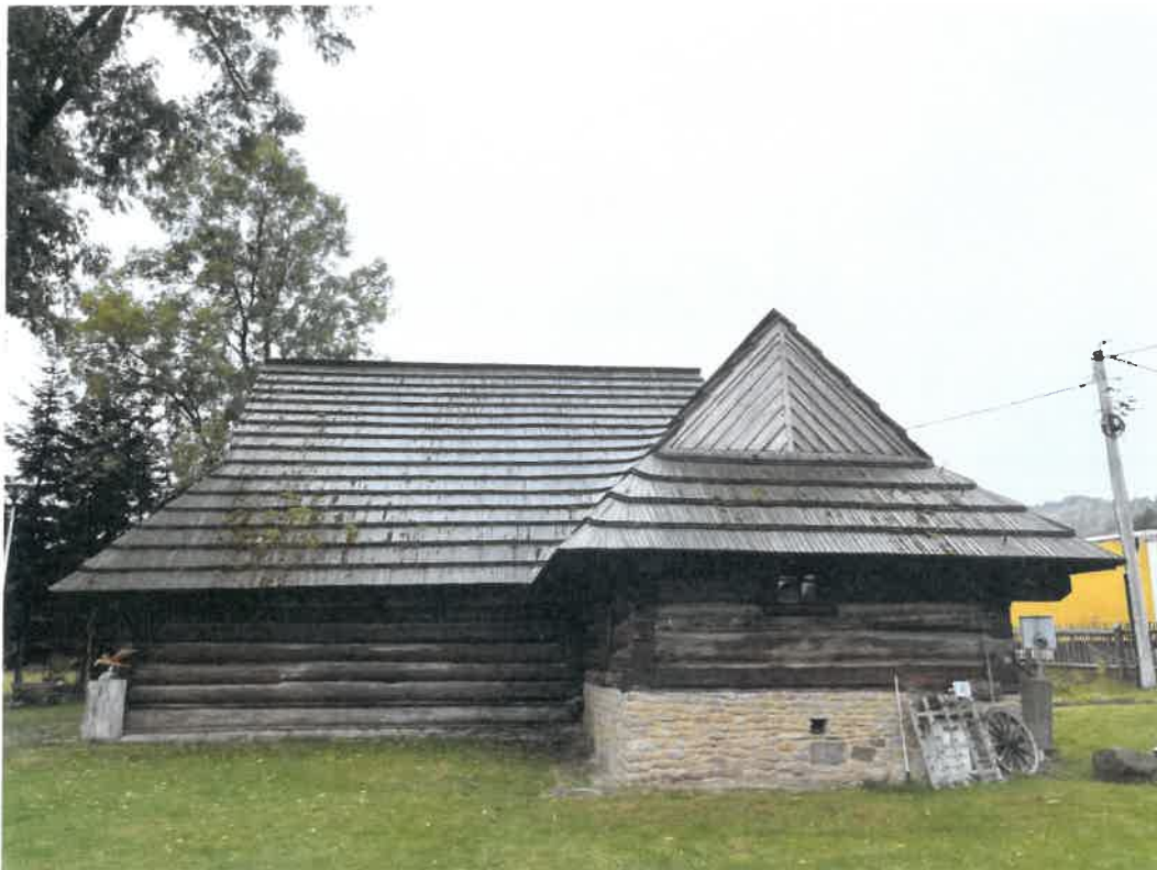
Fot. nr 23, Fot. nr 24 25 Muzeum „Stara Chalupa“, 1739, skansen w Milówce. Strona północna, widok ogólny. Widoczna korozja biologiczna pokrycia gontowego.
